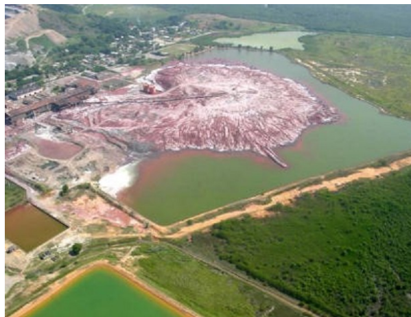
Figura 5- Montanha de rejeitos da falida Cia. Ingá.
